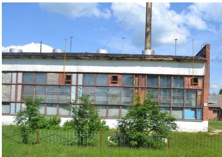
Рисунок 1.29 – Общий вид котельной «Летуново»
