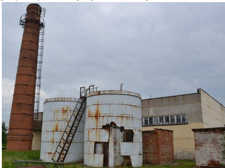
Рисунок 1.30 – Общий вид котельной «Макеево»
