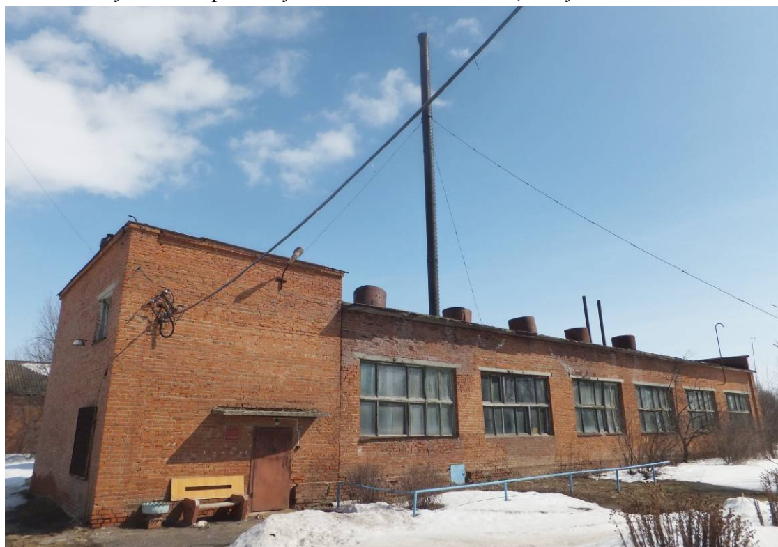
Рисунок 1.34 – Общий вид котельной д. Гололобово
