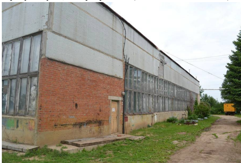
Рисунок 1.28 – Общий вид котельной «Карино»
