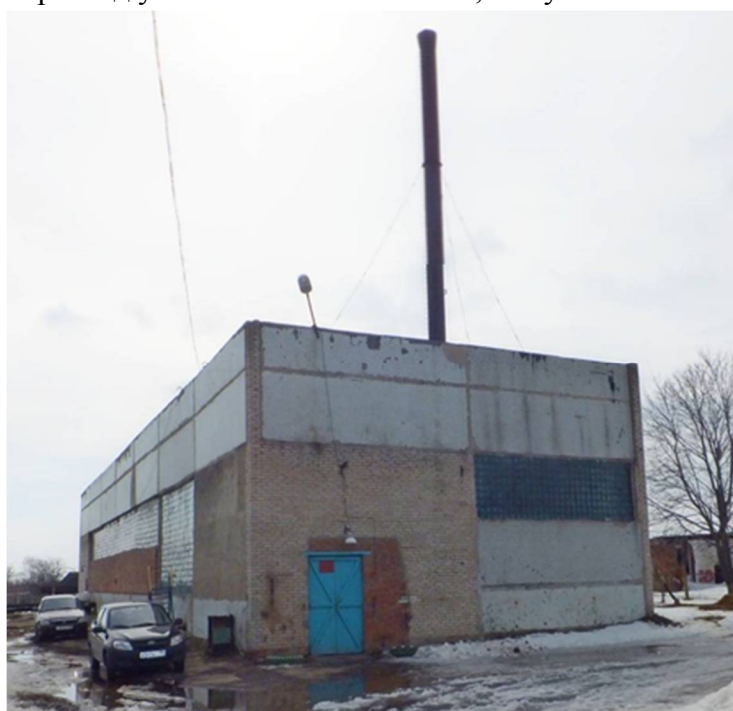
Рисунок 1.35 – Общий вид котельной д. Ерново
