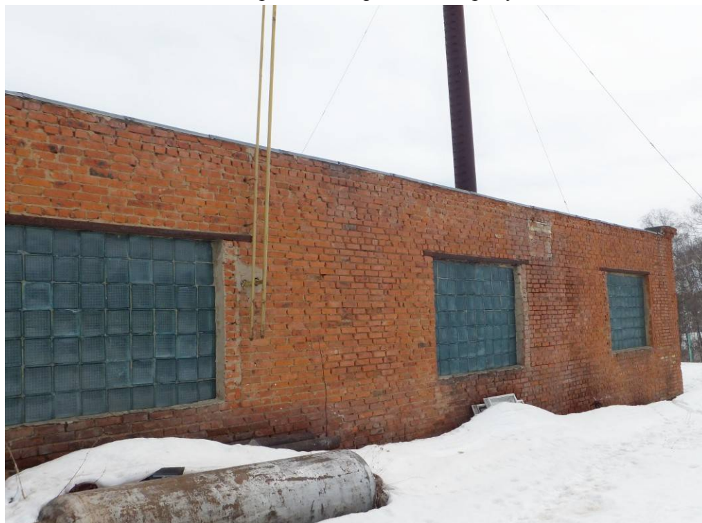
Рисунок 1.32 – Общий вид котельной д. Протекино
