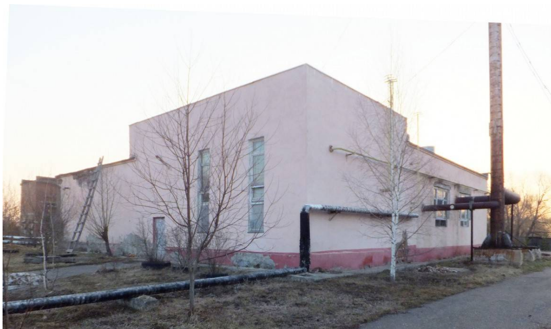
Рисунок 1.31 – Общий вид котельной д. Мендюкино
