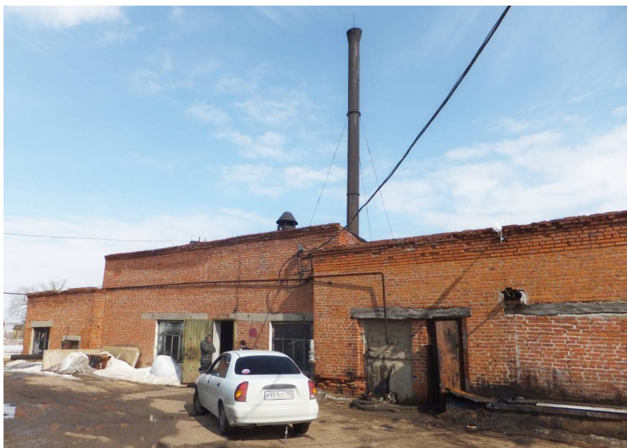
Рисунок 1.36 – Общий вид котельной д. Козловка
