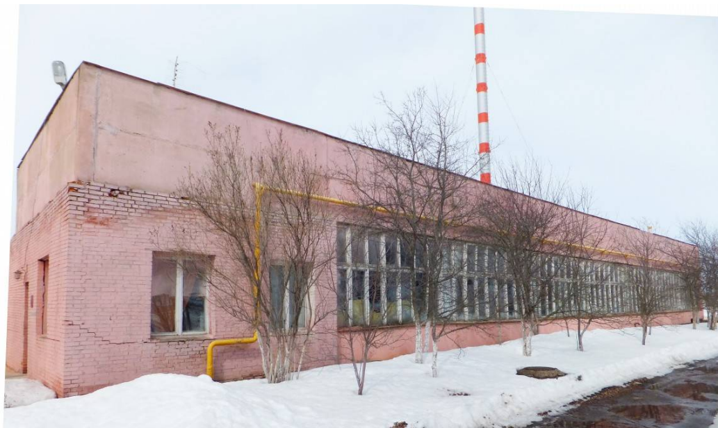
Рисунок 1.33 – Общий вид котельной «Чернево»
